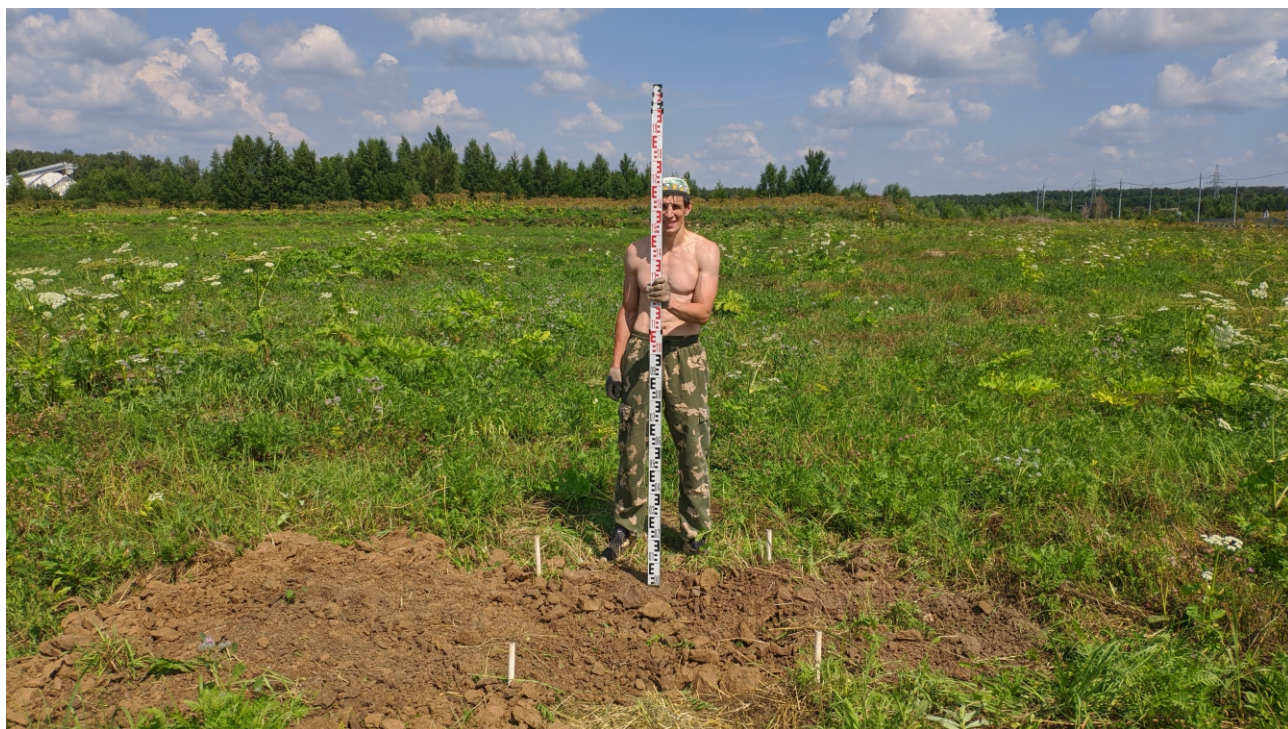
Рис. 29. Шурф 3 после завершения работ. Вид с юга.
